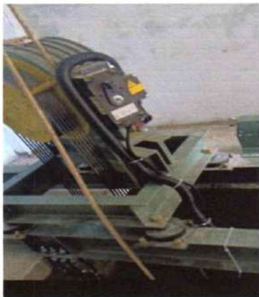
Pembongkaran Mesin Lift Lama
