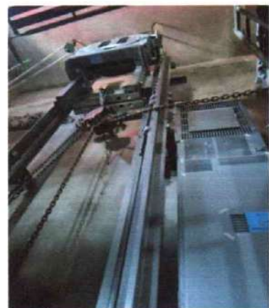
Menaikkan Mesin Lift Yang Baru
