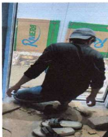
Perakitan/Pemasangan Lift Baru
