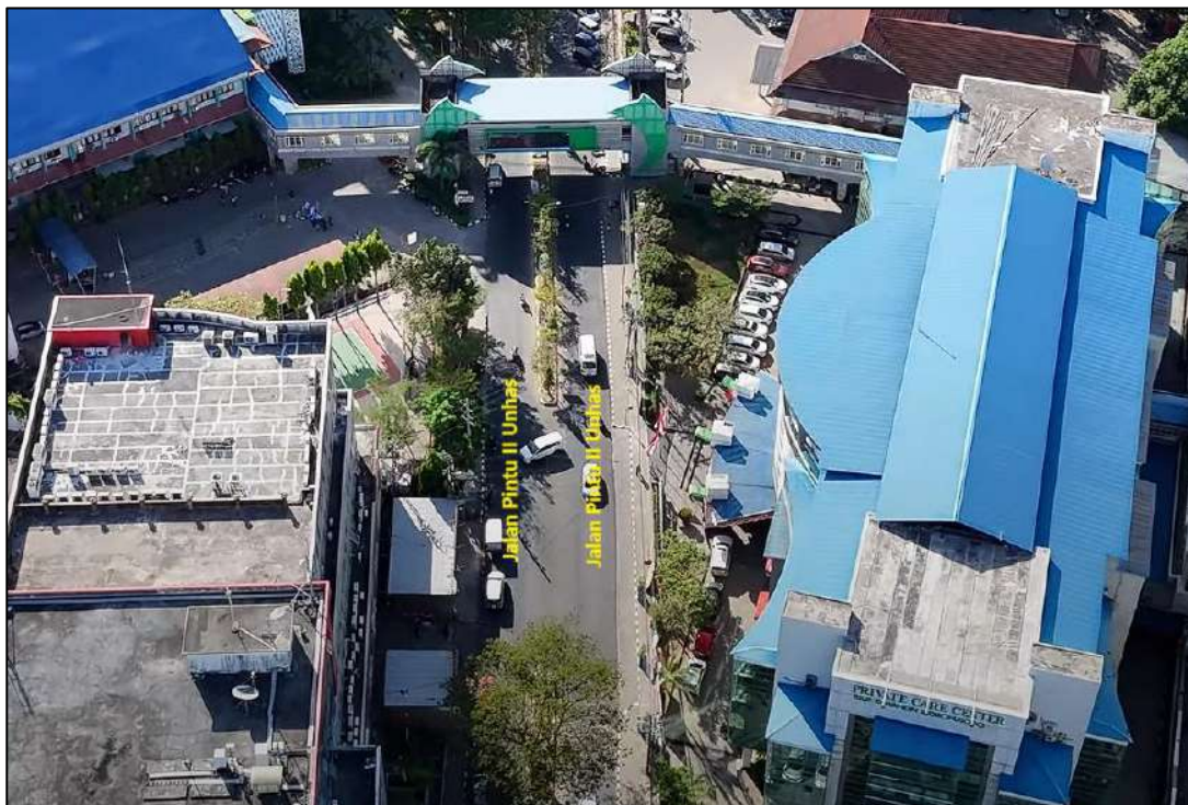
Gambar 3. 12 Kondisi Lengan Jl Pintu II
