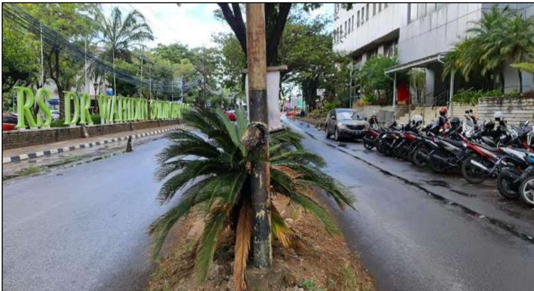
Gambar 3. 13 Kondisi Lengan Jalan Ruas Jalan Pintu II
