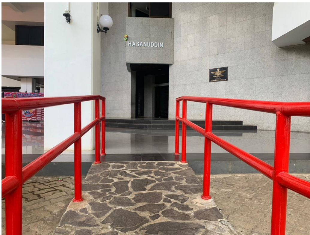
Gambar 3. Akses Desibiltas menuju Ruangan PPID Unhas
